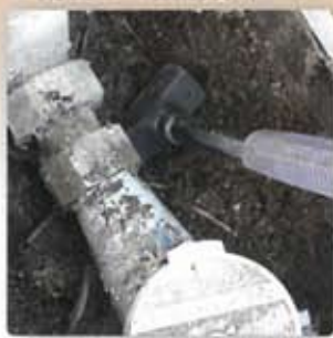
■配管下の掘削作業に
