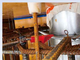
梁貫通補強の最低かぶり厚さ40mmを確認。
