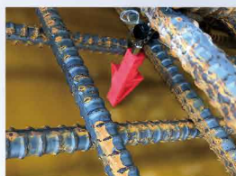
配筋かぶり厚さの見えにくい場合でも確認できる。
