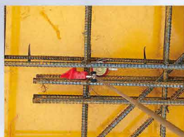
スラブ配筋の鉄筋のあき25mmを確認。
