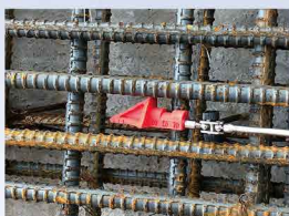
壁配筋の鉄筋のあき25mmを確認。
