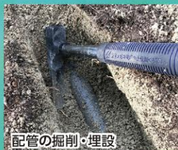
配管の掘削・埋設
