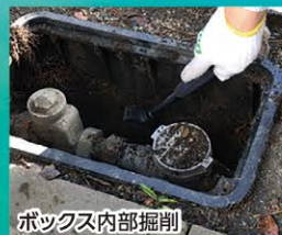
ボックス内部掘削
